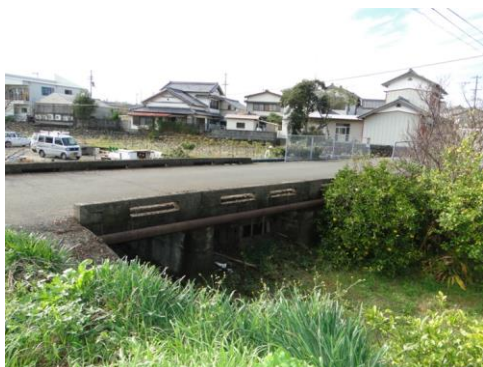
平松橋（昭和 20 年架設）
