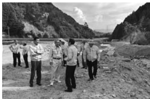
河川の復旧工事
