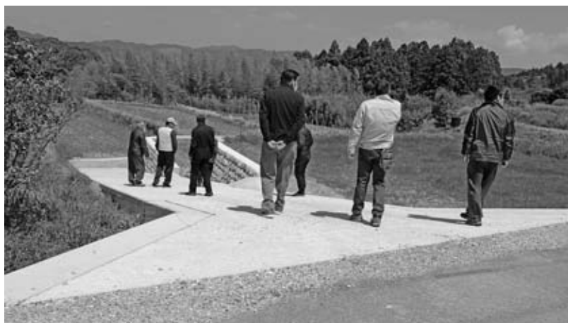
米ヶ岡道路工事
