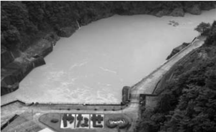
▲魚梁瀬ダム直下
