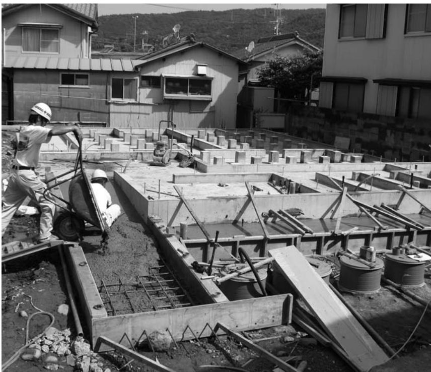
▲建設の進む介護予防拠点施設（樋ノ口）
