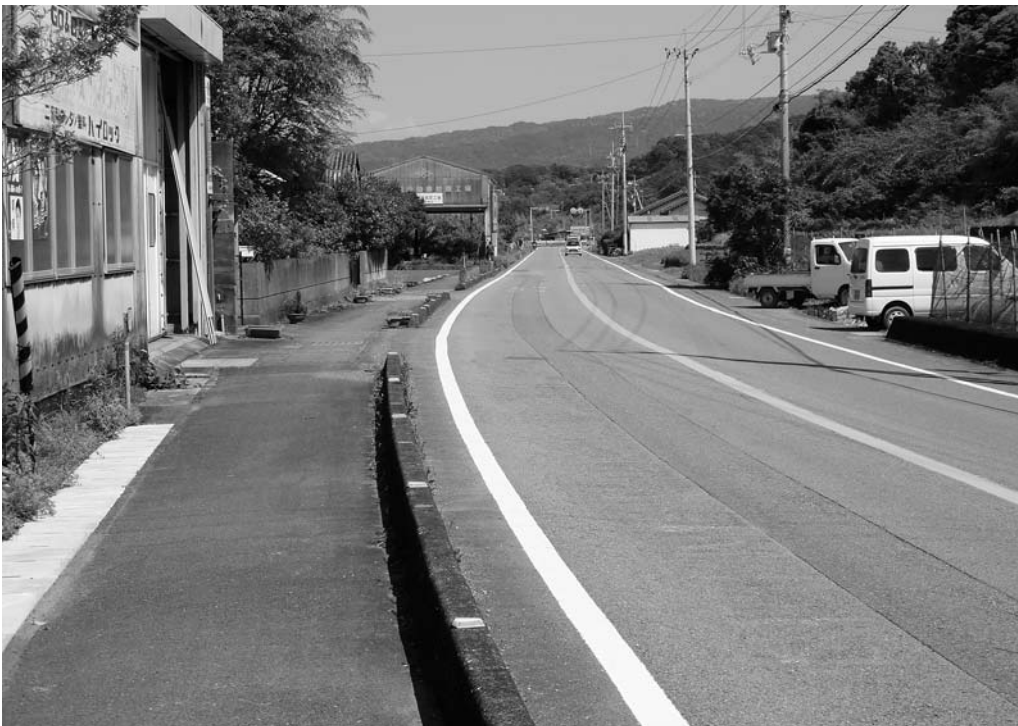
▲道路照明灯が全くない国道55号線
