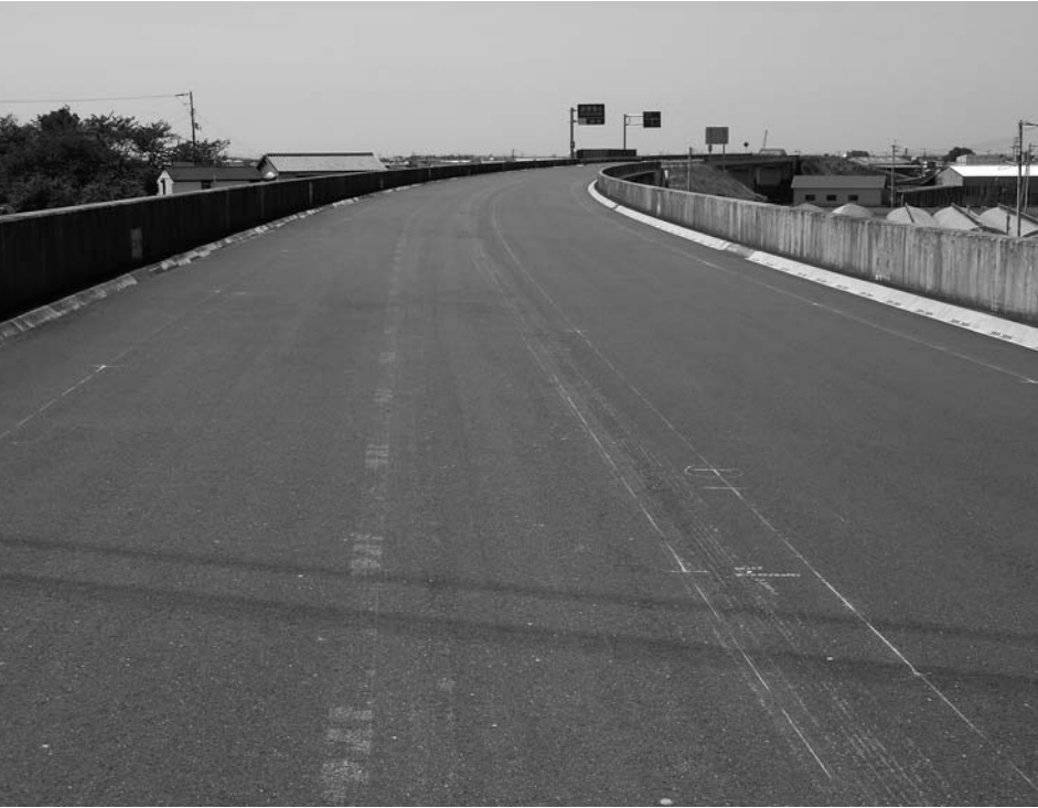
▲奈半利～北川間の一部供用開始が待たれる地域高規格道路
