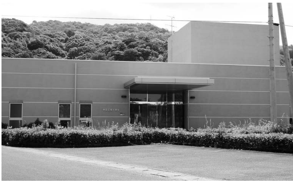
▲多くの利用がある中芸広域火葬場
