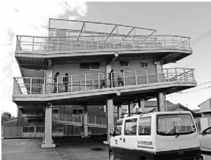
▲第5号津波避難タワー
