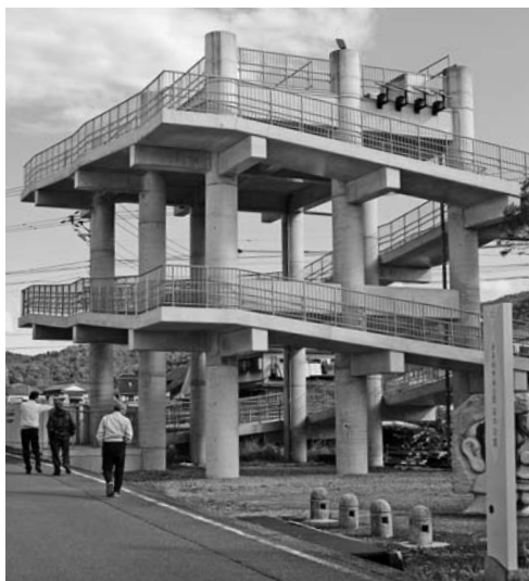
▲第2号津波避難タワー
