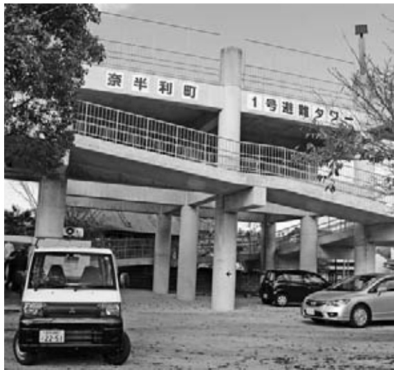
▲第1号津波避難タワー
