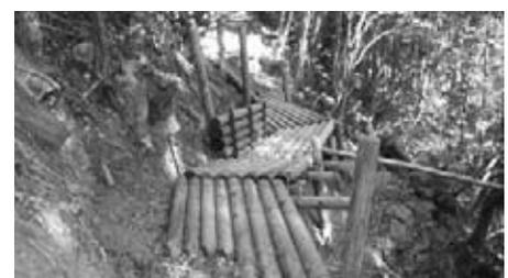
宇川地区への主要線は、町道宇川線しかなく、地震や台風等の災害時には、落石・土砂災害等により、道路が封鎖され孤立の恐れがある集落です。地区では来るべき災害に備え、集落が孤立した場合には、隣接する平地区への避難路及び連絡道として、須川川沿いの里道(昔の生活道)を地区の避難路に位置付けをし、管理を行っております。この度、避難路の一部に補修が必要となったため、休日地区住民(自主防災組織)が集まり、木材やロープなどでお手製の手すりを付け、また崩れかけた箇所には、橋を架けるなどの補強作業を行いました。
