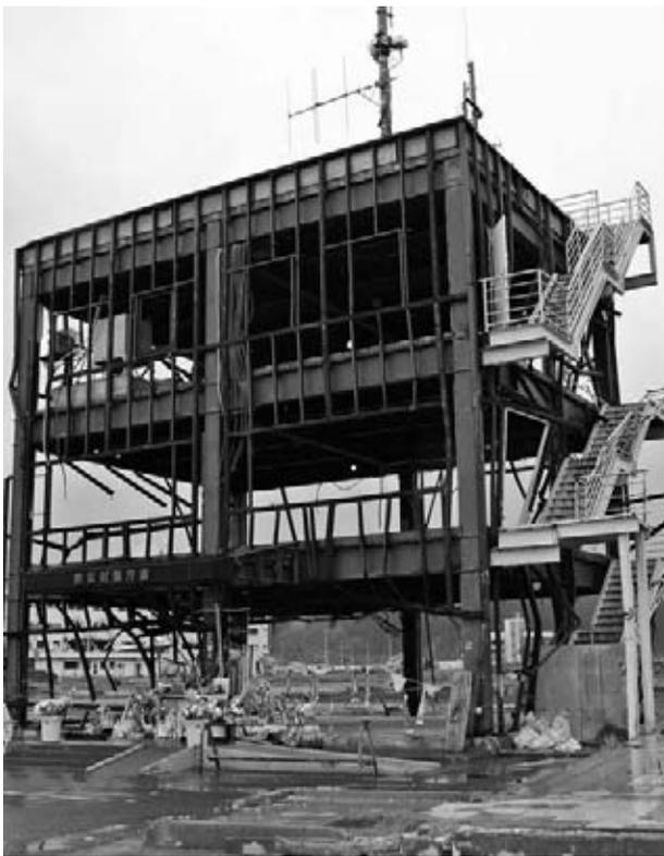
▲津波により破壊された防災対策庁舎（南三陸町）
