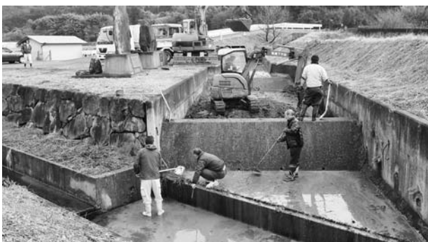
水路泥上げ作業
