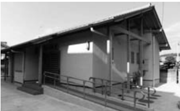
▲完成した樋ノ口いこいの家
