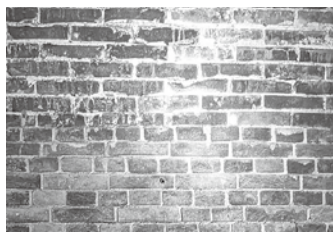
亀瀬隧道のレンガ積み
