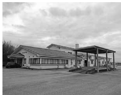
衛生センター
