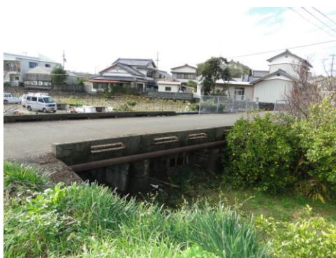
平松橋（昭和 20 年架設）
