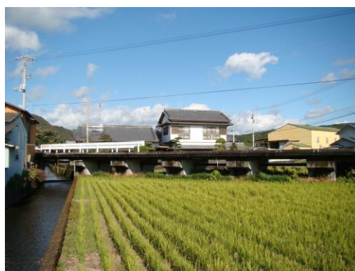
樋ノ口橋（昭和 51 年架設）
