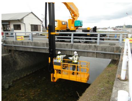
図 3.1 定期点検の様子
