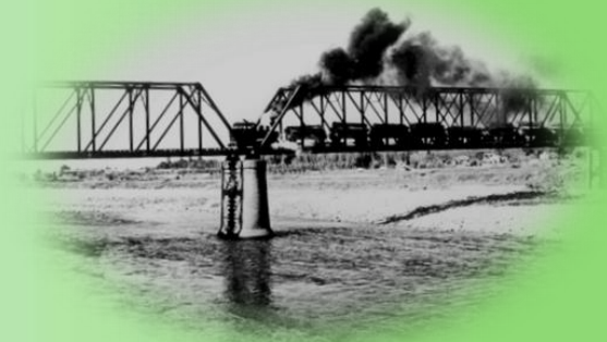
ばし じょうききかんしゃ しょうわ 奈半利川橋を走る蒸気機関車(昭和24年)
