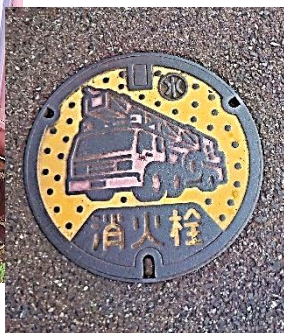
しょうか せん 消火栓
