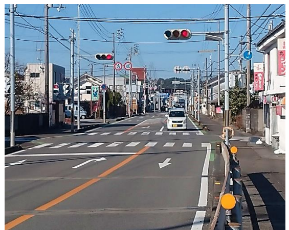
国道55線の通り
