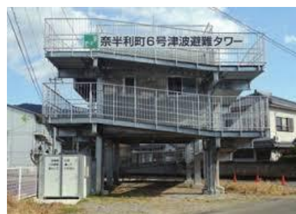
▲津波避難タワー
